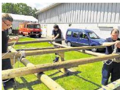
Bei der THW-Grundausbildung: Knoten und Stiche sind beim Gerüstbau nötig, um das Material zu verbinden. Foto: Jung
